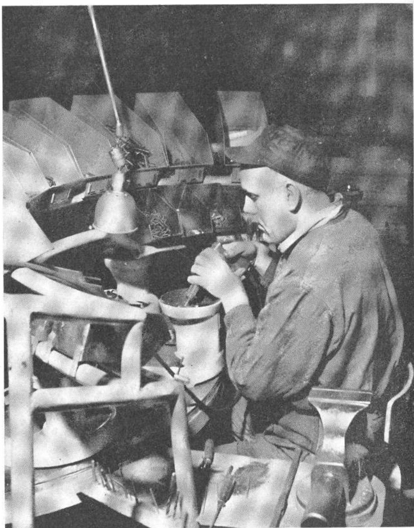
Badrumsvågar i görningen hos Pump-Separators gjuterier.
