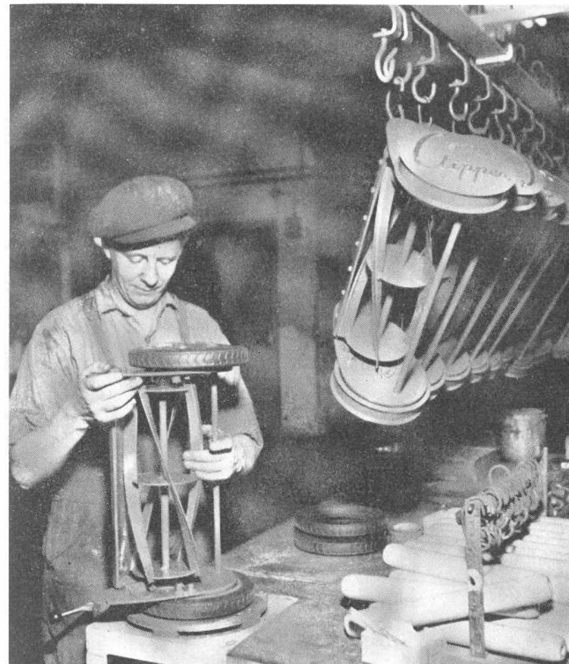
Gräsklippare monteras vid Pump-Separators gjuterier i Katrineholm.
